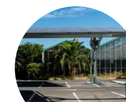
Ombrières de parking
